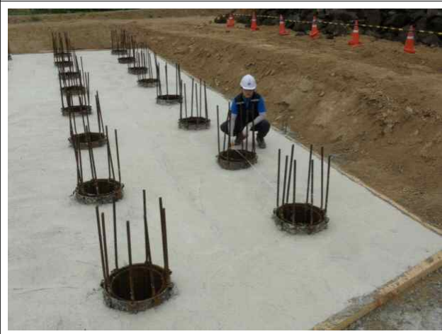
A2(상주방향) 강관파일 간격 측정
