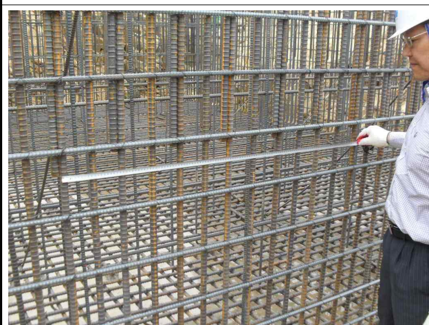
P4(상주방향) 기초부 철근배근간격 측정
