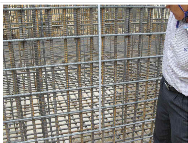
P4(상주방향) 기초부 철근배근간격 측정
